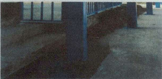
Foto 5: Construcción de grada
