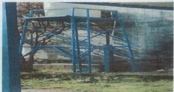
Foto 4: Construcción de torre e instalación de rotoplas
