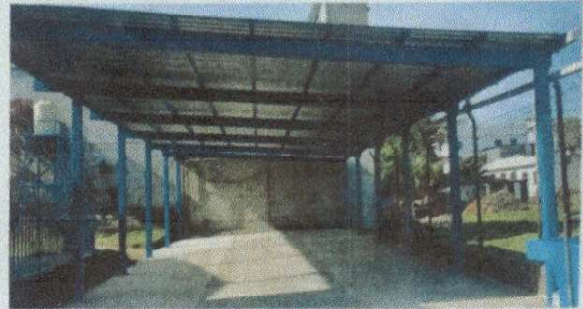
Foto 2: Terminación piso torta y estructura metálica
