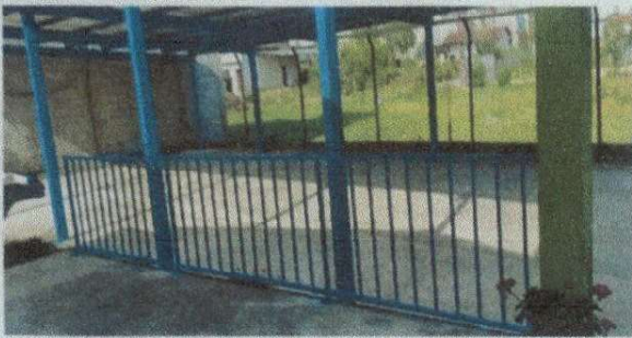
Foto1: Colocación de varandas
